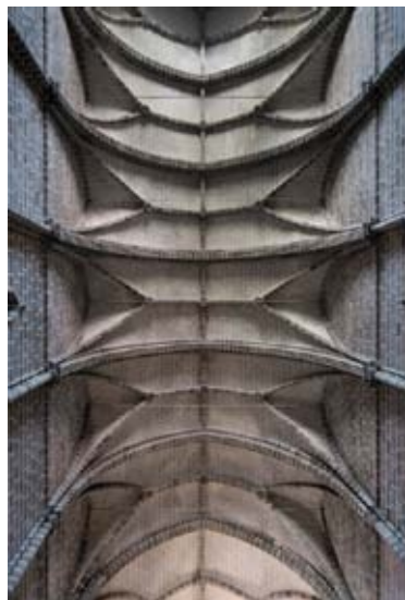
Abóbada nervurada da nave
