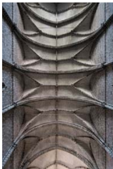
Bóveda nervada de la nave central
